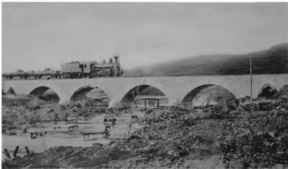
Общий вид моста через р. Бодаохецзы (С. 101)
