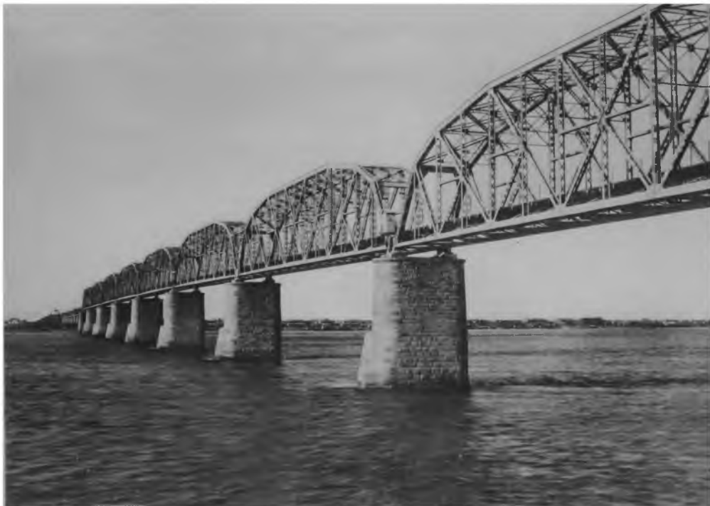
Общий вид моста через р. Сунгари в районе Харбина (С. 136)
